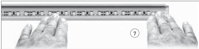
Incollare la strip led all'interno del profilo (7). Glue the LED strip inside the profile (7).
