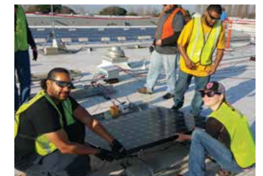
Il lavoro di squadra sui tetti
